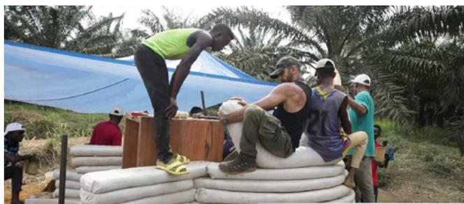
CONSTRUCTION D'UN ÉCO-DÔME AVEC LA TECHNIQUE SUPERADOBE
